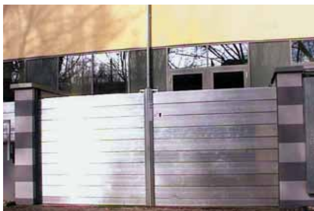
Hochwasserschutztor mit Damm balken
