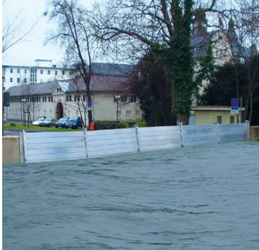
Mobiler Hochwasserschutz mit Dambalken
