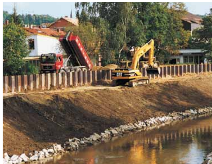
Hochwasserschutzwand mit Stahlspundwand im Bau
