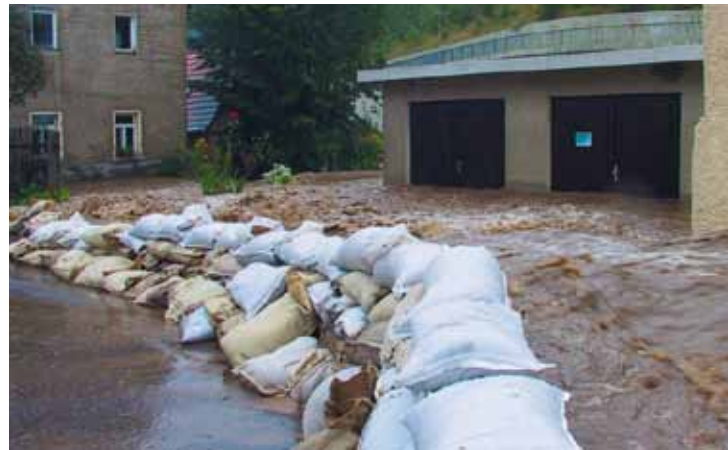
Ein Sandsackwall kann bereits sehr wirkungsvoll sein.
