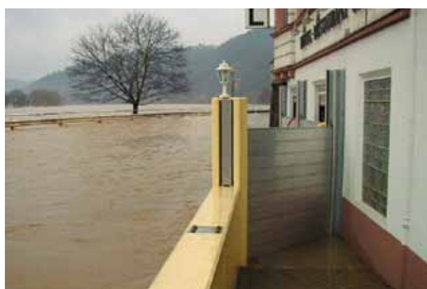
Umlaufender Hochwasserschutz mit teilmobile Schutzelementen
